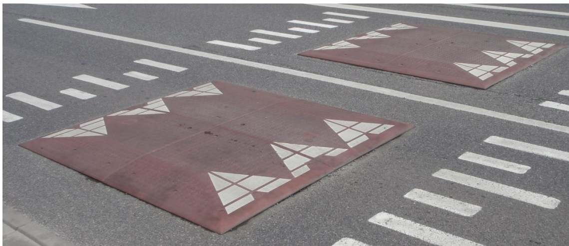
Rys. 7. Progi zwalniające płytowe
